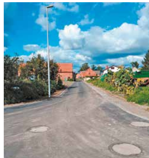
red. Nowa nawierzchnia asfaltowa
