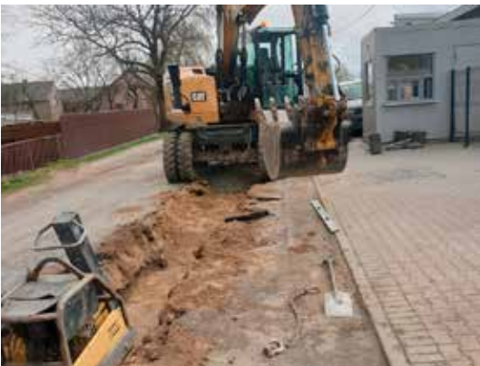
Prace budowlane w miejscowości Chojęcin-Parcele
