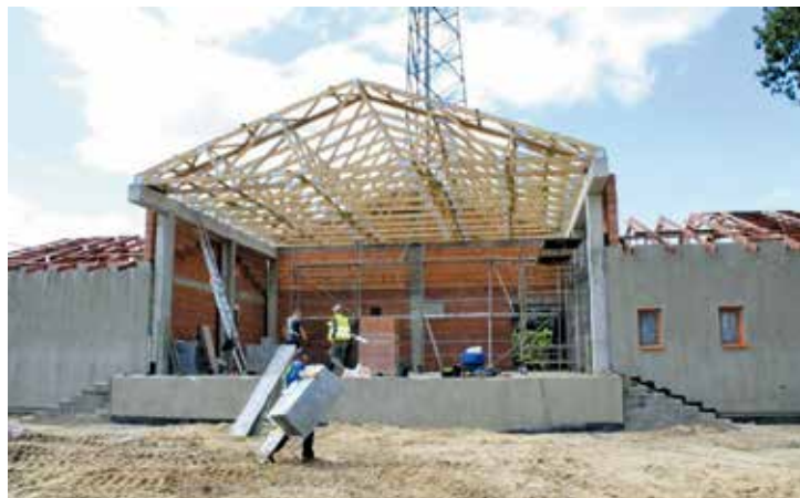
Postęp prac budowlanych sceny na stadionie
