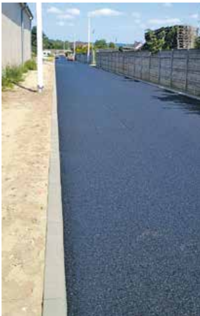
Postęp prac przy ul. Strażackiej
