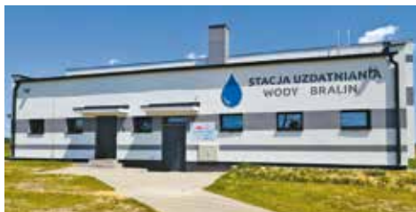
Stacja Uzdadniania Wody w Bralinie
