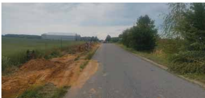
Budowa kanalizacji sanitarnej w miejscowości Nosale
