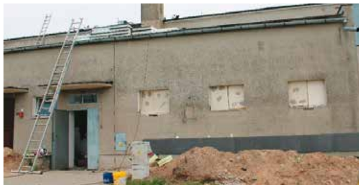
Modernizacja, przebudowa, budowa sieci wodno-kanalizacyjnej oraz Stacji Uzdatniania Wody w Gminie Bralin
