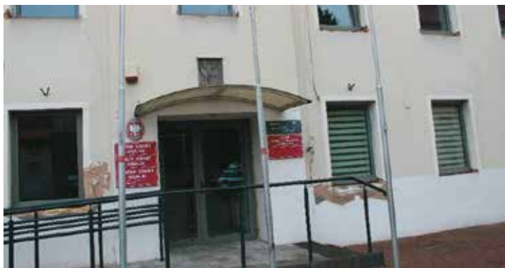
Termomodernizacja budynku Urzędu Gminy Bralin
