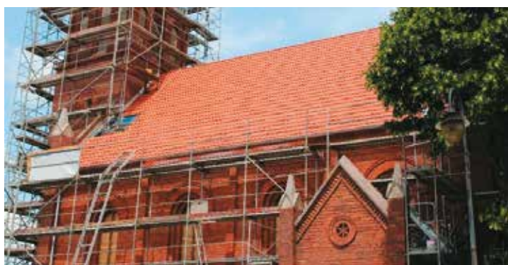
Remont i przebudowa poewangelickiego budynku w Bralinie
