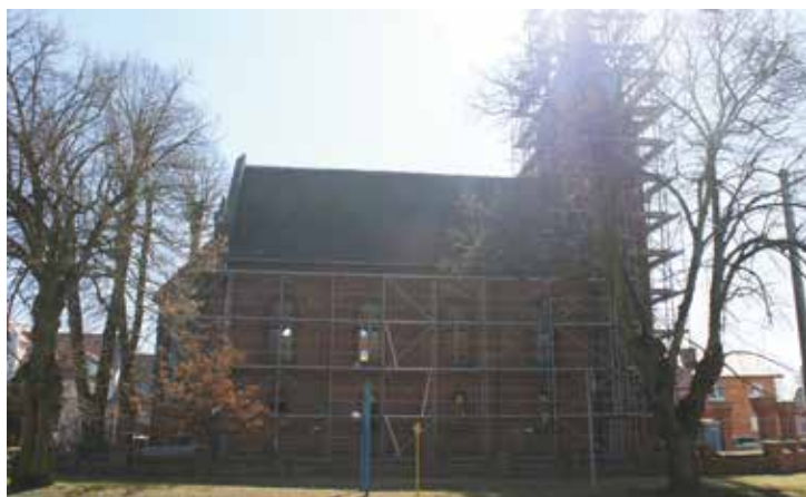
Remont budynku poewangelickiego
