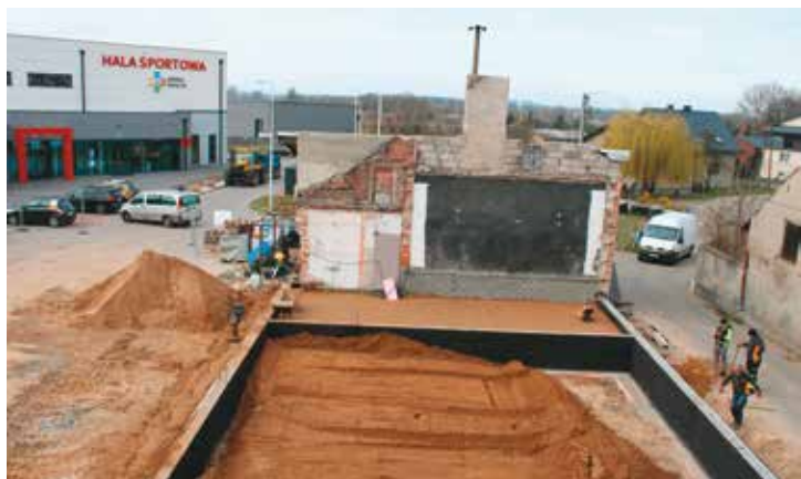
Termomodernizacja budynku Urzędu Gminy Bralin
