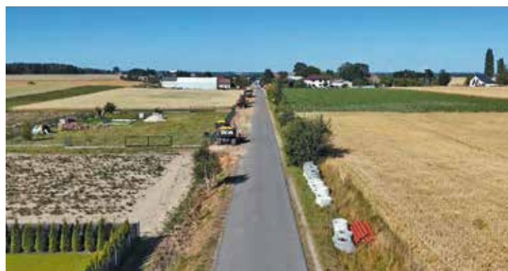
Budowa kanalizacji sanitarnej w Nosalach
