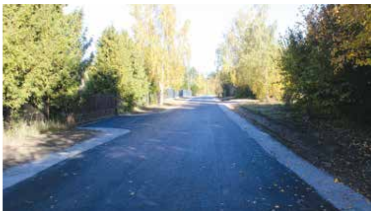
Budowa drogi w Taborze Wielkim
