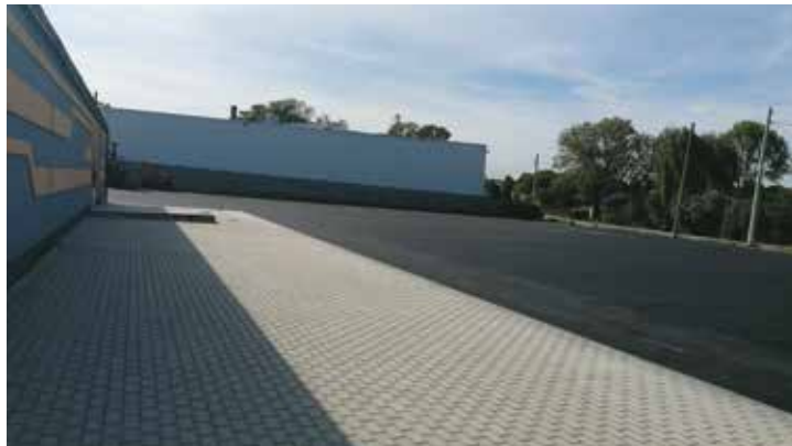
Parking przy Domu Ludowym w Chojęcinie
