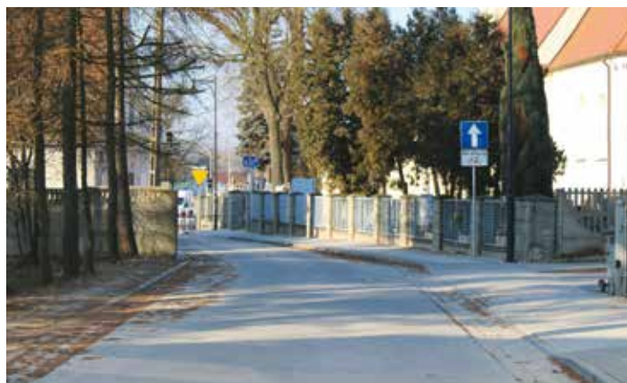
Budowa dróg – ulica Kościelna w Bralinie
