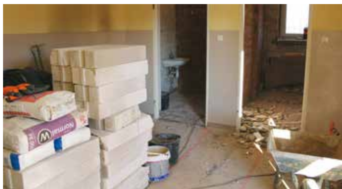
Rozpoczęte prace remontowe w świetlicy „Tęcza”
