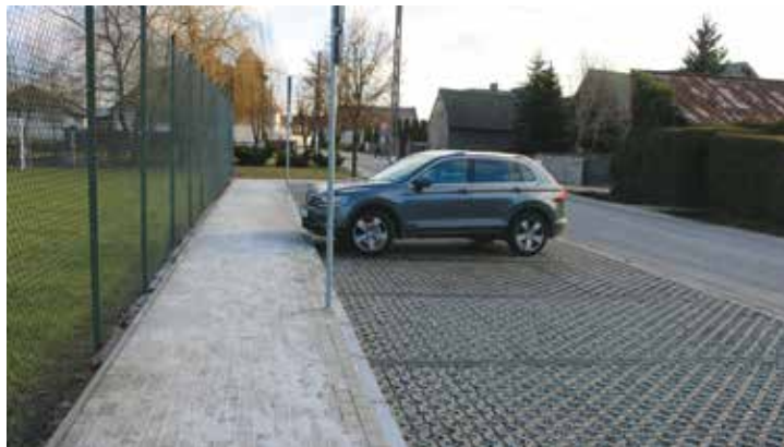
Budowa parkingu przy szkole podstawowej w Nowej Wsi Książęcej
