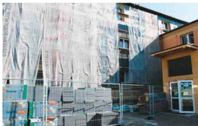
Prace termomodernizacyjne przy bralińskiej podstawówce
