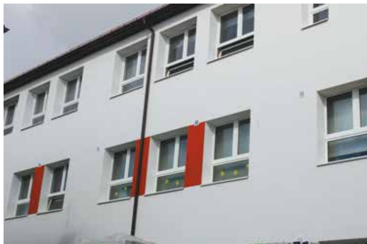
Termomodernizacja bralińskiej podstawówki
