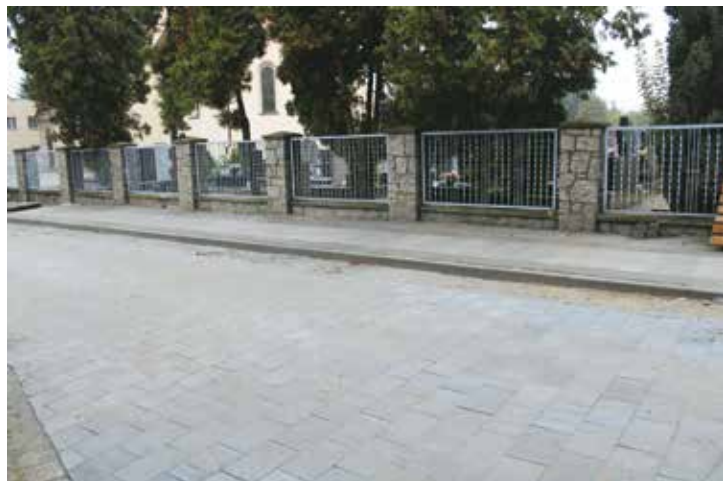
Ulica Kościelna w Bralinie w remoncie
