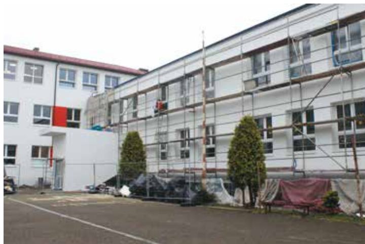
Termomodernizacja bralińskiej podstawówki
