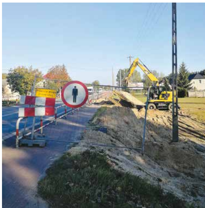
Budowa kanalizacji w Chojęcinie
