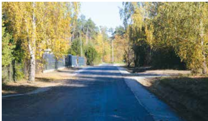
red. Przebudowana droga w Taborze Wielkim
