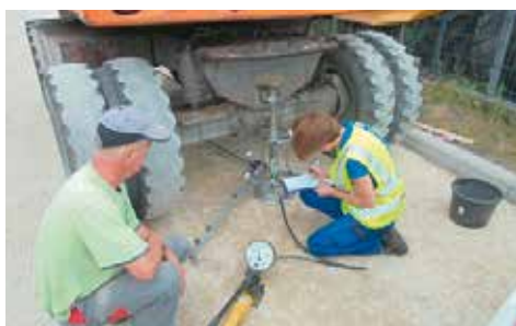
Badanie zagęszczenia podbudowy drogi
