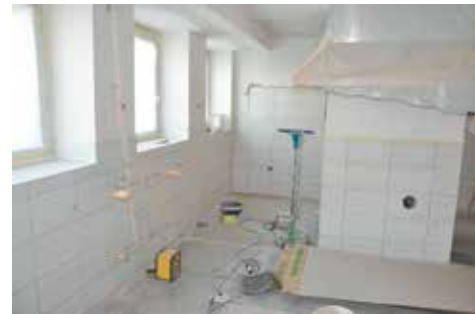
Prace remontowe w kuchni w SP Bralin
