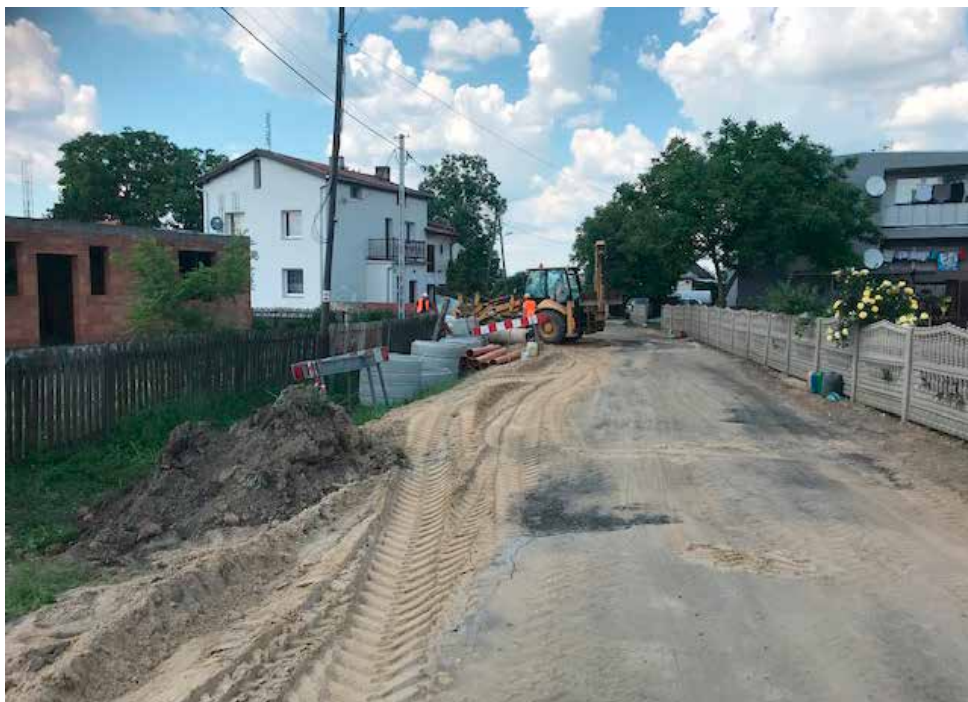
Budowa kanalizacji stwarzała momentami utrudnienia, jednak efekt końcowy wart był wszelkich trudności.
