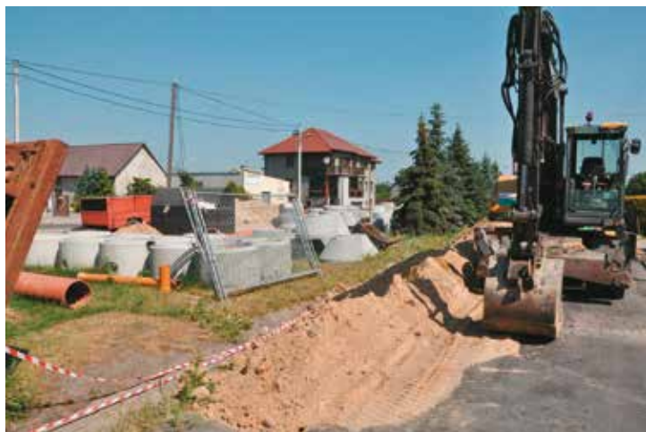
Budowa sieci kanalizacyjnej w Mnichowicach. Jednocześnie zmodernizowano sieć wodociągową.
