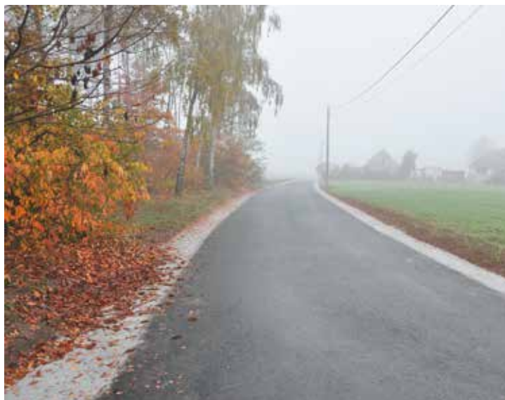
Przebudowa dróg gminnych w Nowej Wsi Książęcej
