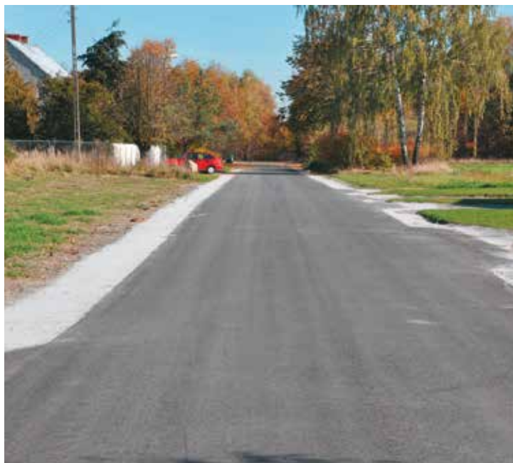
Przebudowa drogi gminnej w Taborze Wielkim
