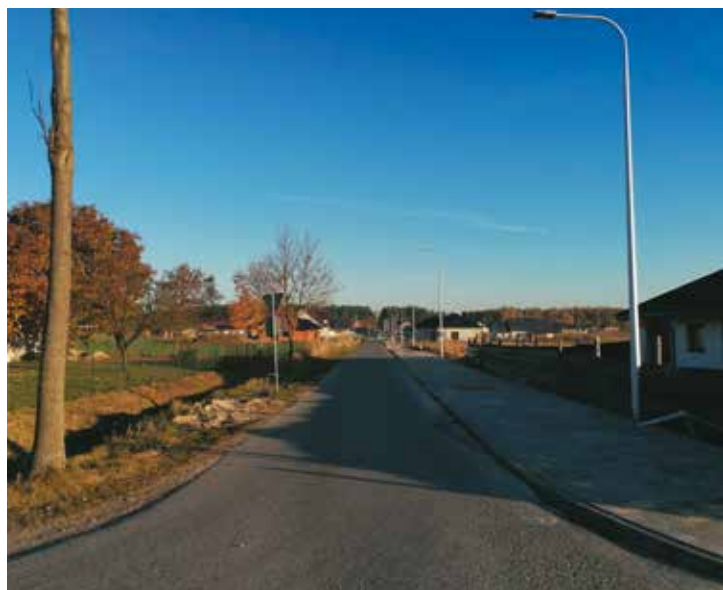
Ścieżka pieszo-rowerowa w Chojeńcinie w trakcie realizacji
