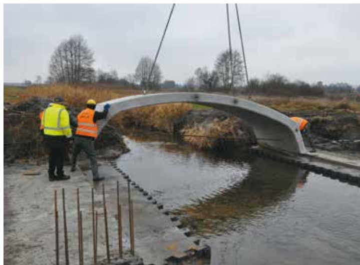
Roboty budowlane nad rzeką Niesób
