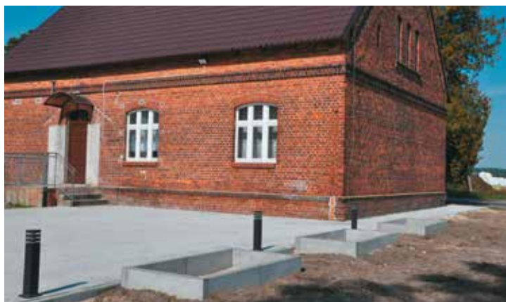
Wokół domu ludowego położono kostkę brukową i zamontowano oświetlenie - sołectwo Tabor Mały
