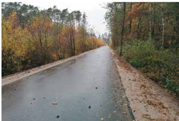
Nowa droga prowadzi do wiaduktu na S8 z Taboru Małego
