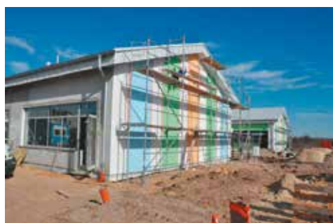
Końcowe prace budowlane
