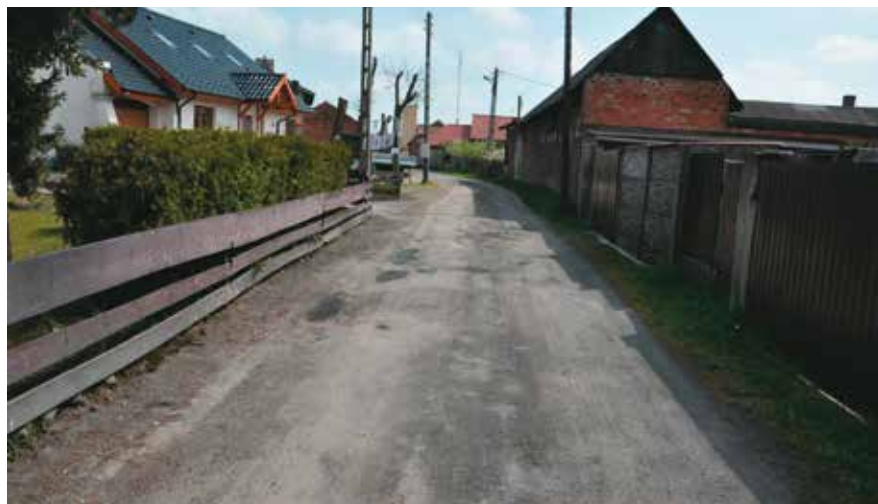
KW Ulica Polna w końcu doczeka się asfaltu
