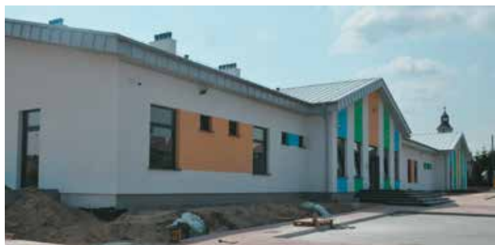
Budowa przedszkola ze żłobkiem na finiszu
