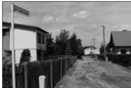
Już niebawem taki wygląd ulicy przejdzie do historii (fot. jack)
