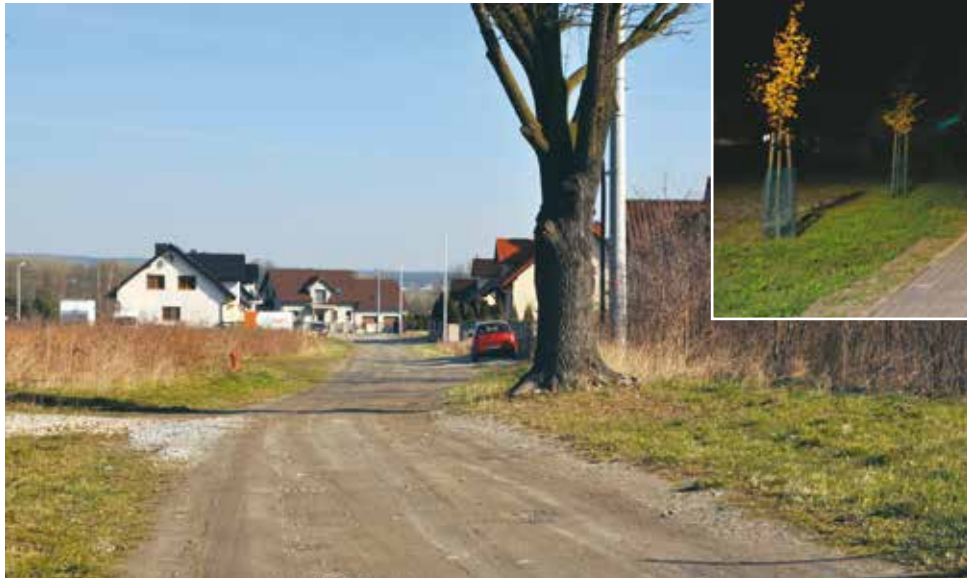
Ul. Ks. J. Ćwiejkowskiego przed remontem
