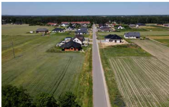
Ulica Pod lasem i Topolowa w Chojęcinie przed budową ścieżki pieszo-rowerowej
