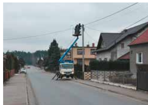
Montaż nowego oświetlenia, ul. Lipowa w Bralinie
