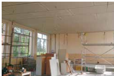
Rozłożone w czasie i podzielone na etapy prace remontowe w domach ludowych
