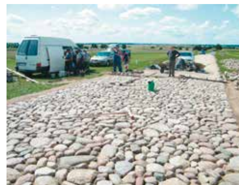
Budowa drogi dojazdowej do sanktuarium Na Półku
