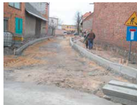
Przebudowa ulicy Krętej
