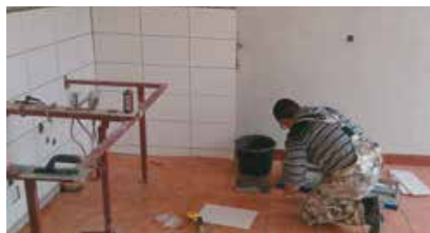
Jeszcze trwają prace remontowe w domach ludowych
