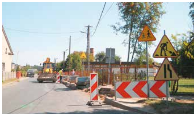
Podczas 1. etapu przebudowy ul. Lipowej w 2013 r.
