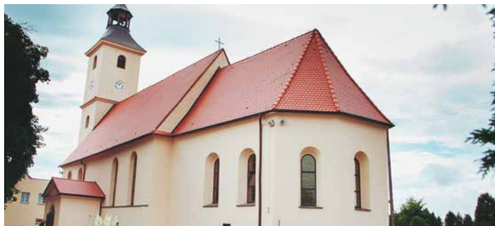
Kościół parafialny pw. św. Anny w Bralinie i jego otoczenie. Ostatni remont w 2013 – elewacja, zagospodarowanie terenu z kamienia granitowego
