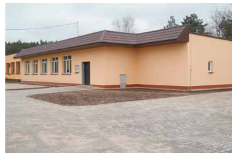
Przebudowa z rozbudową Domu Ludowego w Mielęcínie
