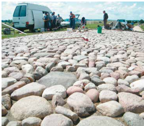
Prace przy Alei Jana Pawła II
