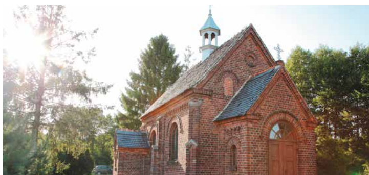
Kaplica pw. św. Jadwigi na łąkach w Mnichowicach. Ostatni remont w 2007 – witraże
