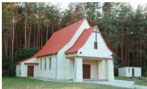
Kaplica cmentarna przy ul. Lipowej. Ostatnie remonty w 2009 i 2013 – elewacja, aleje cmentarne z kostki betonowej
