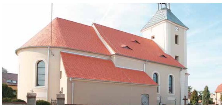
Kościół filialny pw. św. Katarzyny Aleksandryjskiej w Mnichowicach. Ostatni remont w 2010-2012 – nowy dach, elewacja, wzmocnienie fundamentów, odwodnienie itd.
