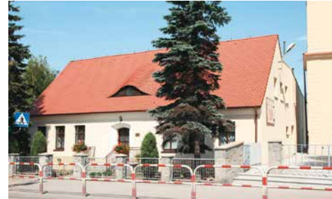
Plebania. Ostatnie remonty w 2009 – elewacja, kostka betonowa
