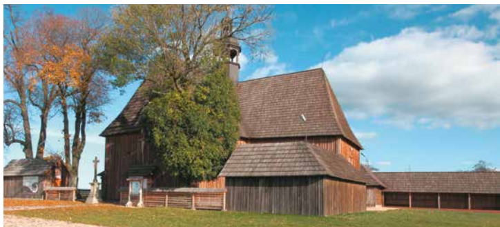
Sanktuarium Maryjne Na Półku pod Bralinem. Prace remontowe i konserwatorskie w latach 2010-2013
