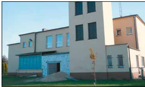
OSP Bralin potrzebuje pomieszczeń magazynowych, dlatego trwa rozbudowa remizy
