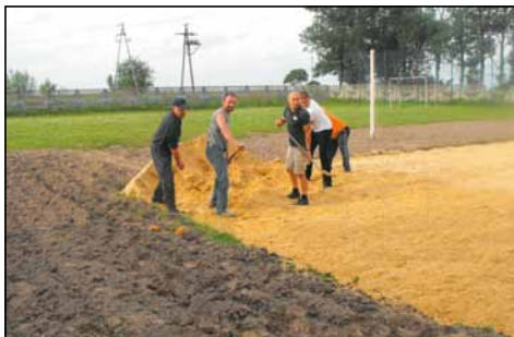
Trwa układanie kostki na placu piknikowym
