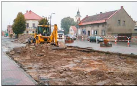
Trwa zrywanie starej nawierzchni drogi. Zdjęcie zrobiono 20 listopada 2011 r.
