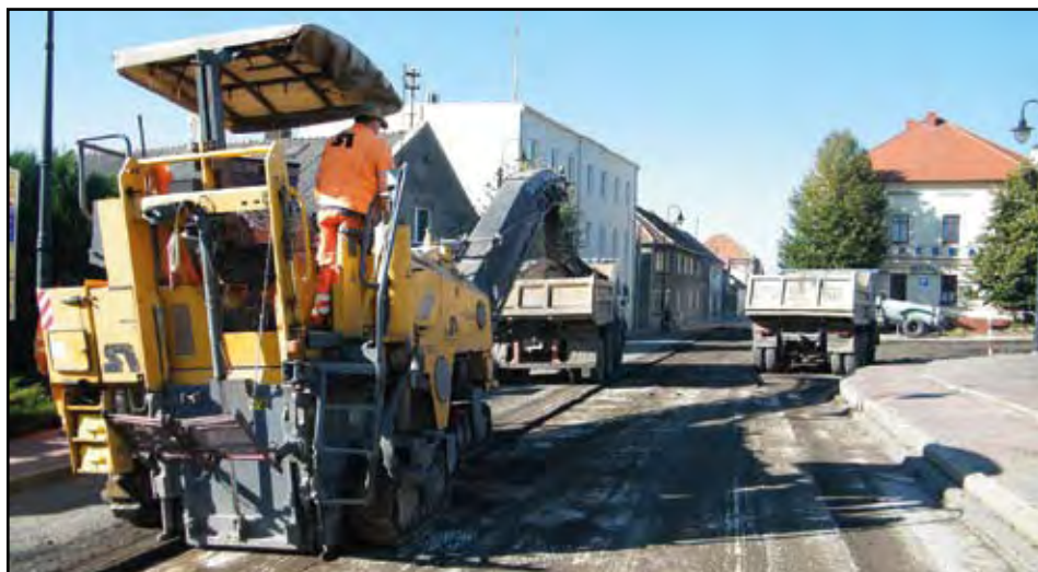
Trwające od 17 października 2011 r. roboty budowlane zmieniają oblicze bralińskiego Rynku i przyległej ul. 3 Maja (fot. jack)
