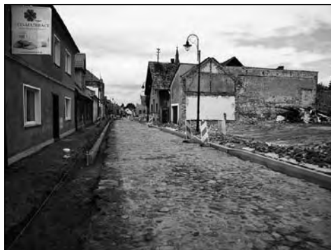
Ul. 3 Maja doczekała się gruntownej naprawy (fot. jack)
