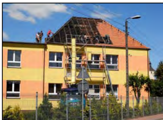
Nadbudowa frontowego skrzydła rozpoczęła się w pierwszych dniach lipca 2011 roku (fot. jack)
