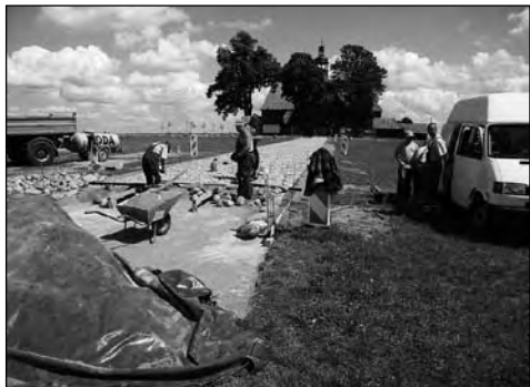
Prace przy budowie drogi dojazdowej do Pólka zostały już zakończone (fot. jack)
