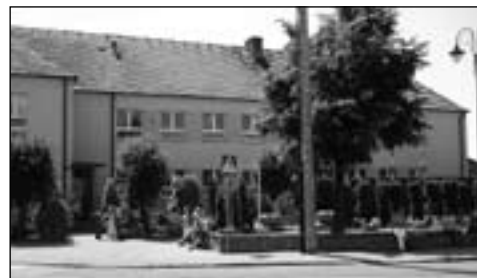
Tuż po zakończeniu roku szkolnego rozpocznie się nadbudowa tego skrzydła szkoły (fot. jack)
