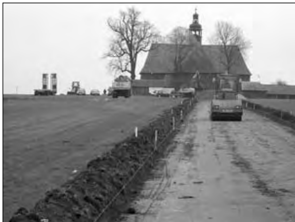
Budowa drogi ruszyła 11 kwietnia br. (fot. Jack)
