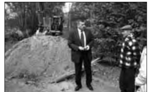
Wójt gminy Roman Wojtyśiak z sołtysem Romanem Dębskim na placu budowy (fot. K. Zagrobelna)
