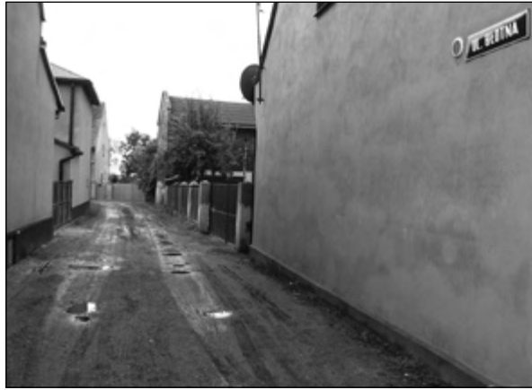
Obecny stan ulicy Błotnej niebawem przejdzie do historii
