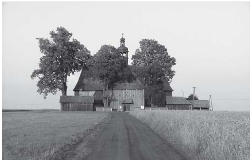
Prace remontowo-konserwatorskie na Półku rozpoczną się w 2010 r. (fot. jack)
