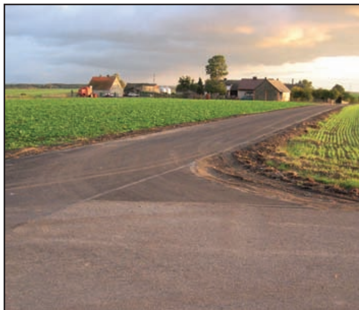
Droga gminna w Chałupkach (fot. S. Bąk)
