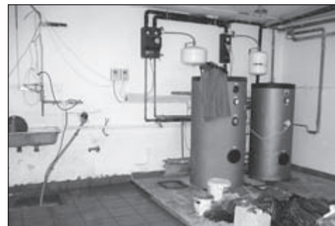
Sierpniowe prace modernizacyjne w kotłowni przedszkola (fot. jack)
