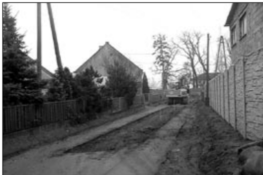
Trwają prace przy budowie kanalizacji sanitarnej i deszczowej na ul. Krótkiej w Bralinie.
