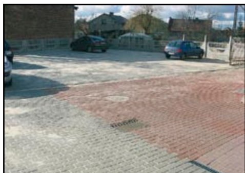
Tworzenie centrum miejscowości Bralin – budowa parkingu na placu po rozbiórce stodoły przy UG Bralin. Wydatki z budżetu w 2007 r. – ok. 100 tys. zł.
