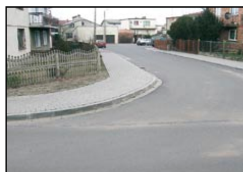
Budowa ulic: Słonecznej, Kalinowej, Jodłowej i Bocznej w Bralinie. Wydatki z budżetu w 2007 r. – ok. 128,4 tys. zł, wartość całej inwestycji – ok. 624,1 tys. zł.
