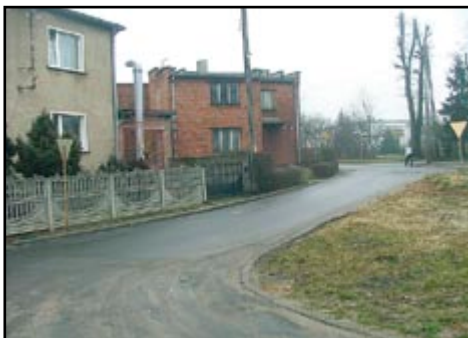
Położenie nawierzchni na fragmencie drogi między ul. Kościuszki a Lipową. Wydatki z budżetu w 2007 r. – ok. 13,5 tys. zł.
