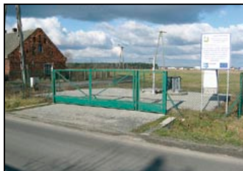
Budowa kanalizacji sanitarnej w Chojęcinie. Wydatki z budżetu w 2007 r. – ok. 115,5 tys. zł, wartość całej inwestycji – ok. 469,8 tys. zł.
