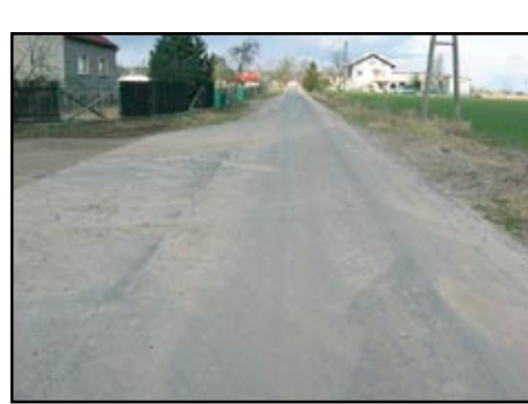
Budowa drogi gminnej w Taborze Wielkim. Wydatki z budżetu w 2007 r. – ok. 179,2 tys. zł.
