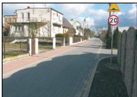
Budowa ulicy Ogrodowej w Bralinie. Wydatki z budżetu w 2007 r. – ok. 578,7 tys. zł, wartość całej inwestycji – ok. 580,9 tys. zł.
