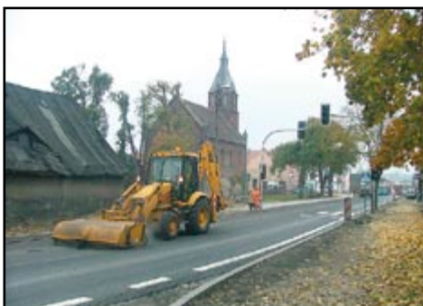
Modernizacja drogi krajowej E 8. Inwestor – Generalna Dyrekcja Dróg Krajowych i Autostrad w Poznaniu, wartość całej inwestycji – ok. 9-10 mln zł
