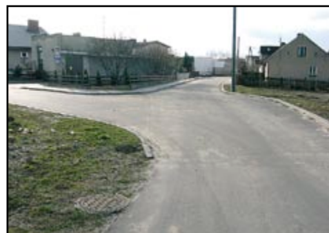
Budowa ulicy Wiosennej i części ulicy Kaczej w Bralinie. Wydatki z budżetu w 2007 r. – ok. 324,5 tys. zł, wartość całej inwestycji – ok. 325,7 tys. zł.
