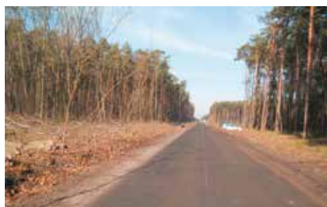
Teren pod budowę już przygotowany
