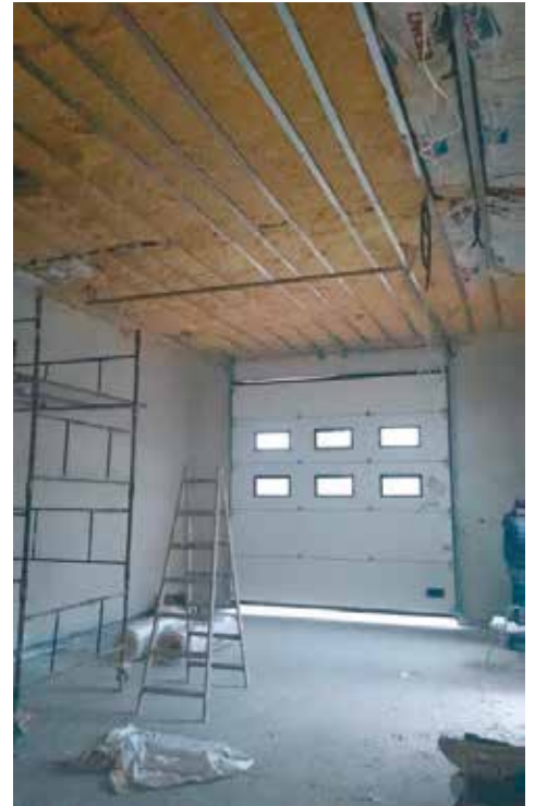
Podczas montażu sufitu podwieszanego w garażu OSP
