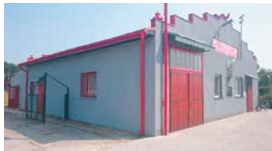
Budynek OSP w Goli w nowej szacie
