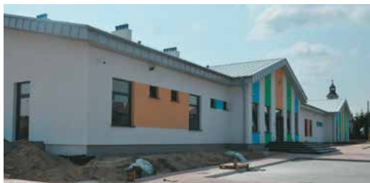
Budowa przedszkola ze żłobkiem na finiszu
