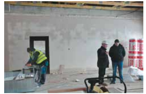
Prace są już daleko zaawansowane
