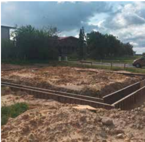
Ławy fundamentowe pod dom ludowy w Nosalach
