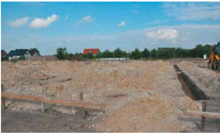
Stan budowy przedszkola na dzień 8 lipca br.
