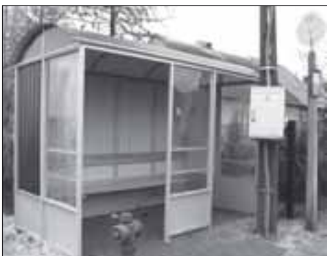
Wyremontowana wiata przystankowa stanęła w Chojęcinie (fot. mak)
